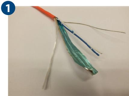
Dénuder seulement la gaine extérieure de 2 po, en veillant à ne pas endommager les câbles à l'intérieur.
