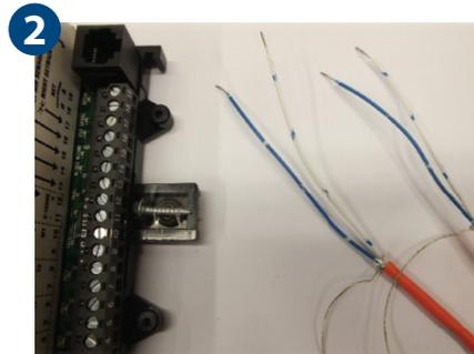
Retirer le papier d'aluminium et soutenir le filament (lorsqu'applicable), séparer tous les fils, et dénuder chaque bande de conducteurs isolés.
