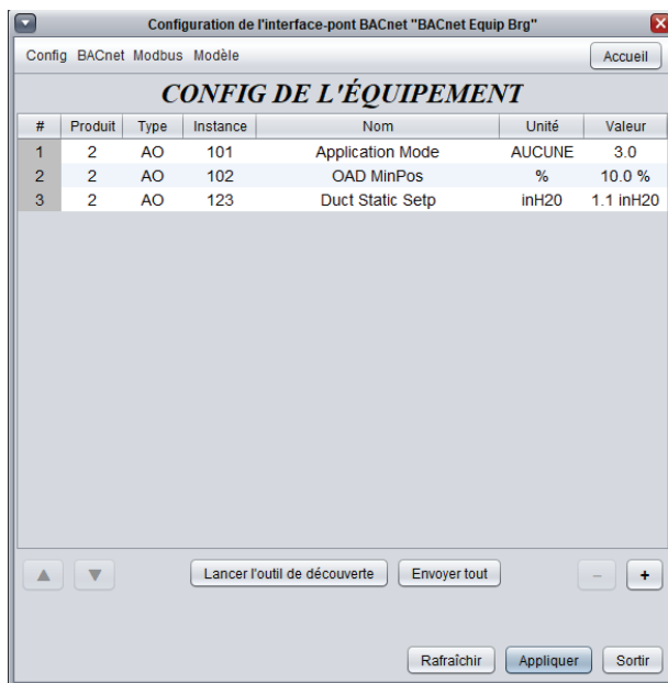
Figure 24 - Fenêtre de configuration du périphérique BACnet
